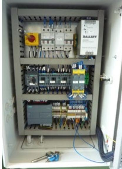
Construit à l'aide de composants des meilleures marques internationales, ce type de coffret permet de gérer intégralement le cycle de dosage et de vidage des bennes au moyen d'un automate. Il dispose d'un asservissement avec la ligne de production et le circuit d'arrêt d'urgence.
