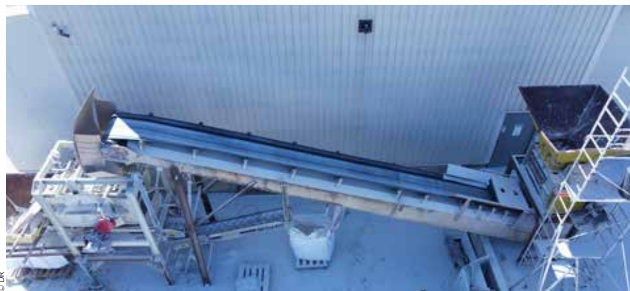
→ L'entreprise vient de monter une nouvelle installation assurant le broyage des déchets de plâtre.
